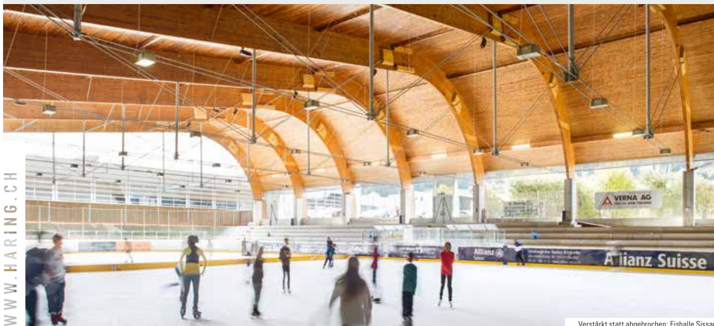
Verstärkt statt abgebrochen: Eishalle Sissach
