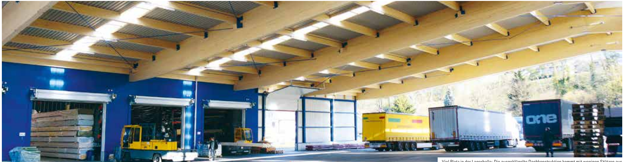
Viel Platz in der Lagerhalle: Die ausgeklügelte Dachkonstruktion kommt mit wenigen Stützen aus
